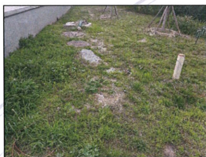
临时堆土区撒播草籽绿化
