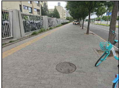
透水铺装及行道树
