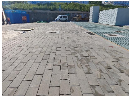
道路及管线工程防治区-透水砖铺装 (2025年7月)
