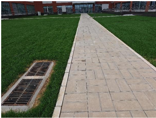
道路及管线工程防治区-透水砖铺装 (2025年9月)
