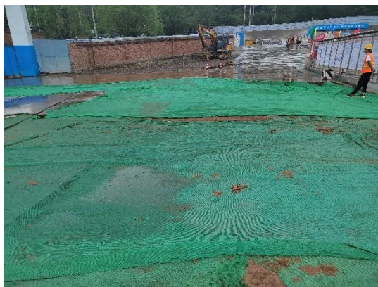
建筑物工程防治区-防尘网覆盖 (2023年6月)
