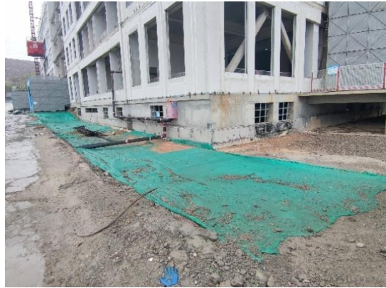
建筑物工程防治区-防尘网覆盖 (2024年4月)
