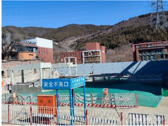
防尘网覆盖 道路及管线工程防治区 (2024年3月)
