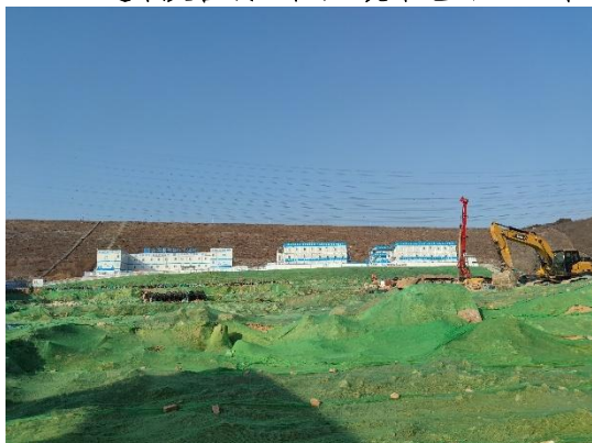
绿化工程区-防尘网苫盖 道路及管线工程区-洗车池 (2023年4月)
