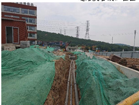
道路及管线工程区-防尘网覆盖 (2025 年 6 月)
