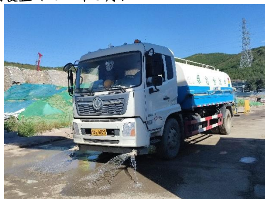
防尘网苫盖 洒水降尘 道路及管线工程区 (2022年9月)
