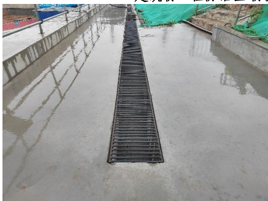
道路及管线工程区-临时排水沟 (2023年7月)
