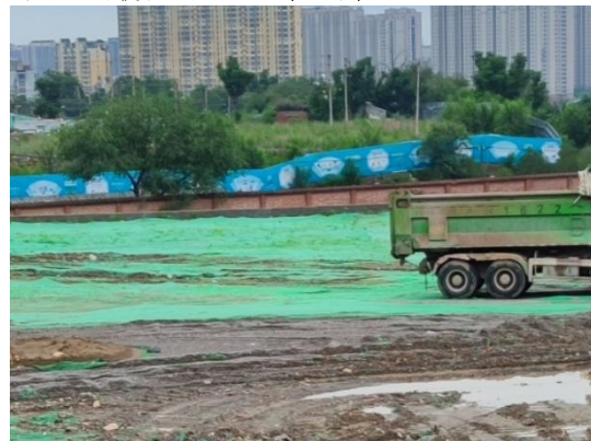
建筑物工程区-防尘网覆盖（2022年7月）
