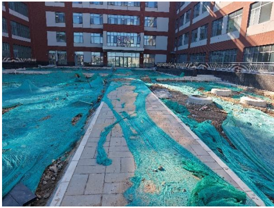
道路及管线工程防治区-透水砖铺装 (2025年7月)
