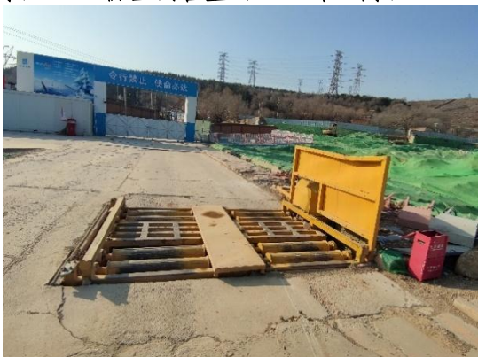
绿化工程区-防尘网苫盖 道路及管线工程区-洗车池 (2023年4月)
