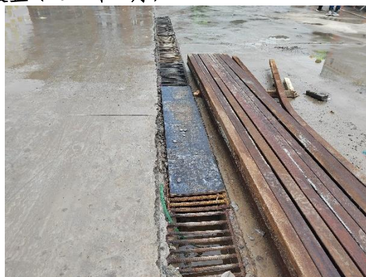
防尘网覆盖 临时排水沟 施工生产生活区 (2024年10月)
