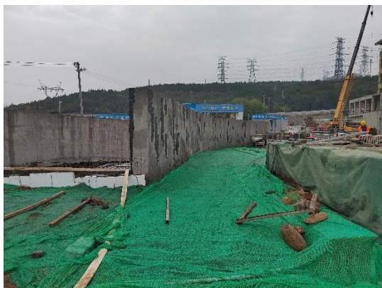
建筑物工程防治区-防尘网覆盖 (2024 年 10 月)
