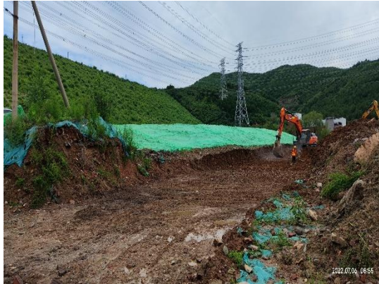
道路及管线工程区-绿化工程区-防尘网覆盖（2022年7月）
