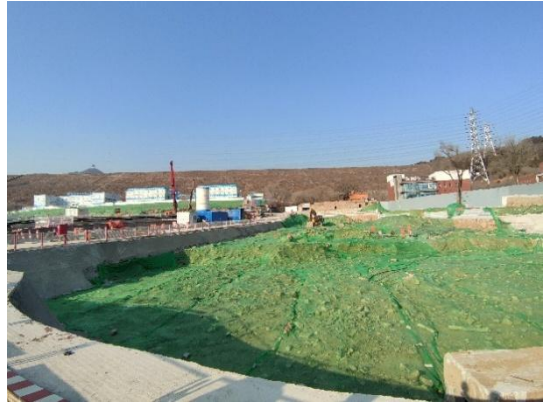
临时排水沟 防尘网苫盖 道路及管线工程区 (2023年4月)
