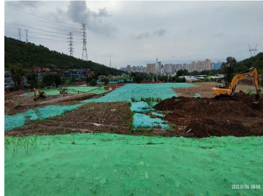
道路及管线工程区-绿化工程区-防尘网覆盖（2022年7月）
