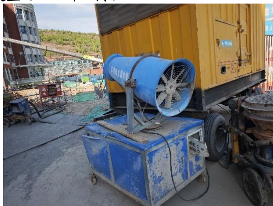
道路及管线工程区-洒水降尘 (2025 年 4 月)
