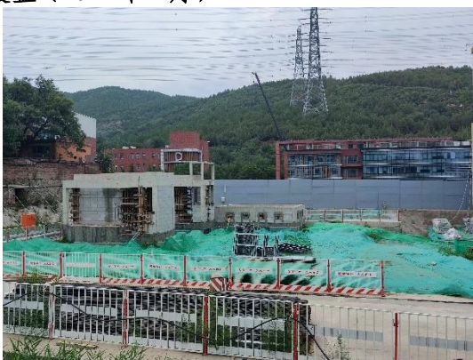
洒水降尘 防尘网覆盖 道路及管线工程区 (2024年7月)
