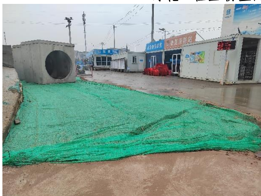
防尘网覆盖 临时排水沟 施工生产生活区 (2024年10月)
