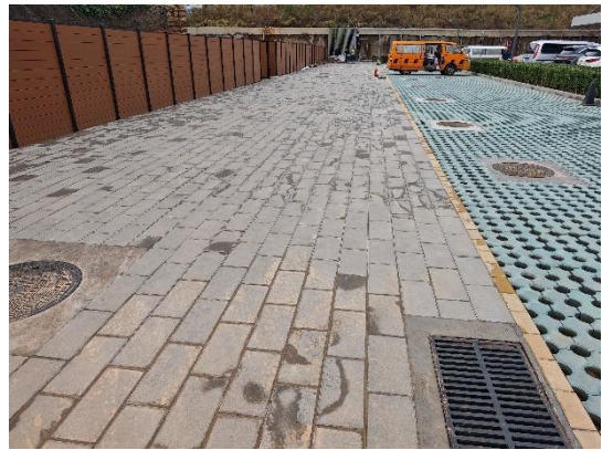
道路及管线工程防治区-透水砖铺装 (2025年9月)
