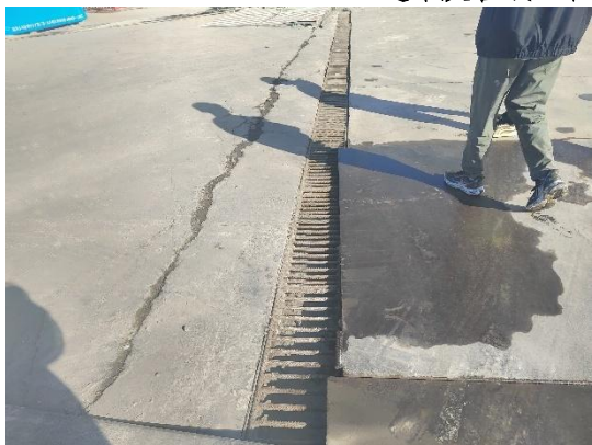
道路及管线工程区-临时排水沟 (2023年10月)
