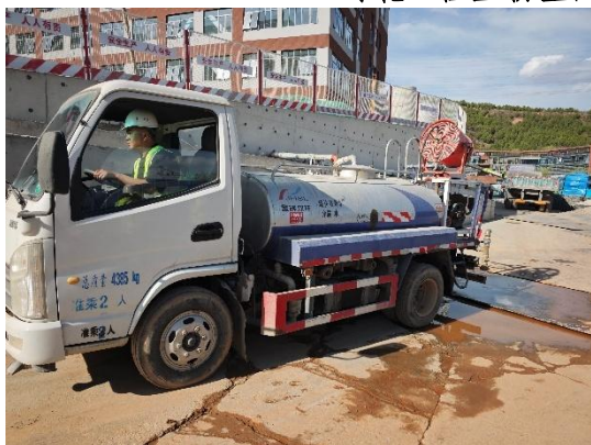
道路及管线工程区-洒水降尘 (2025 年 4 月)
