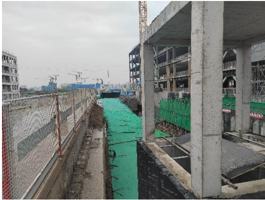
建筑物工程防治区-防尘网覆盖 (2024年4月)
