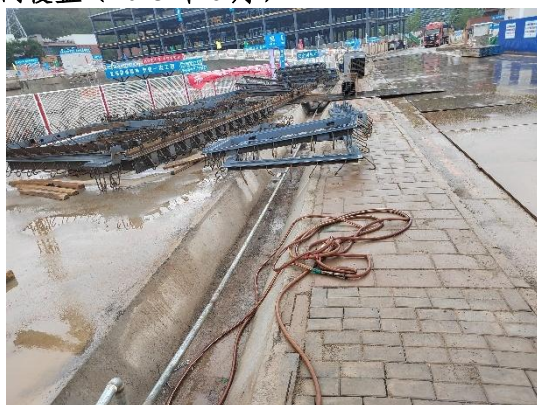
道路及管线工程区-临时排水沟 (2023年7月)
