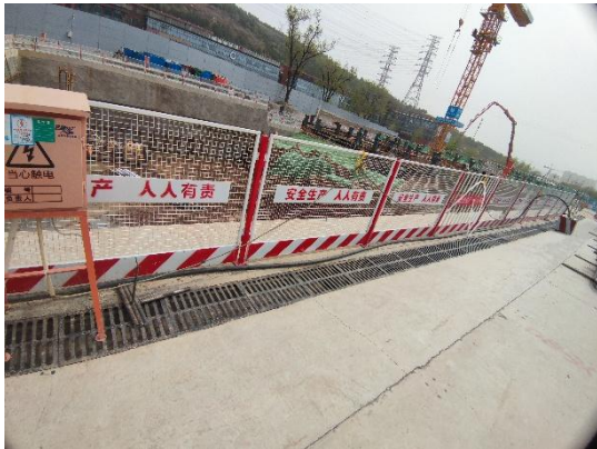
临时排水沟 临时沉沙池 道路及管线工程区 (2023年4月)
