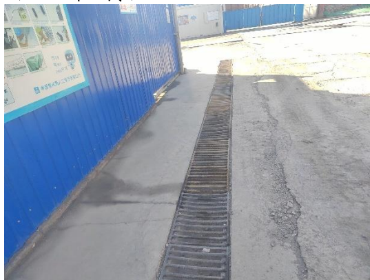
道路及管线工程区-临时排水沟 (2023年10月)
