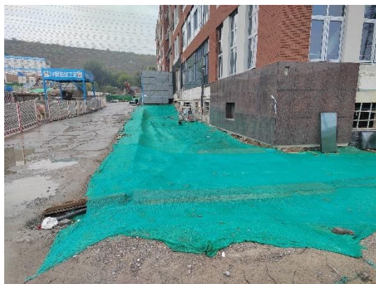
建筑物工程防治区-防尘网覆盖 (2024 年 10 月)
