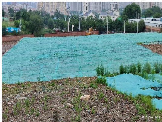
建筑物工程区-防尘网覆盖（2022年7月）
