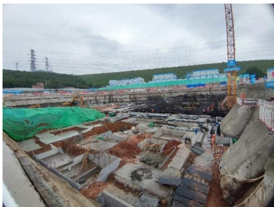
建筑物工程防治区-防尘网覆盖 (2023年6月)
