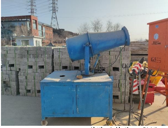
道路及管线工程区-洒水降尘 (2023年4月)
