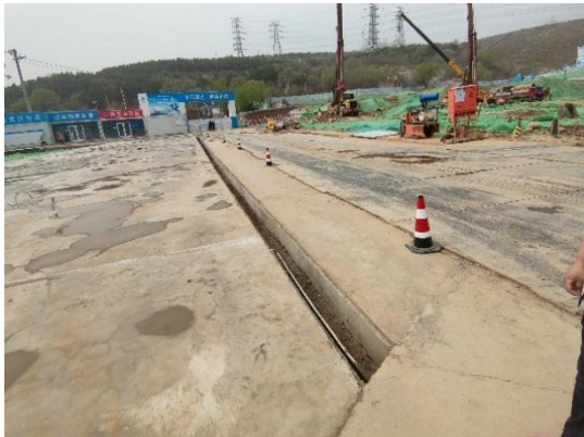
临时排水沟 防尘网苫盖 道路及管线工程区 (2023年4月)
