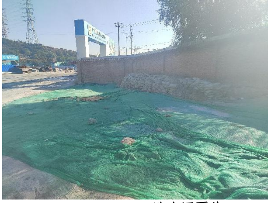
防尘网覆盖 道路及管线工程防治区 (2023年10月)
