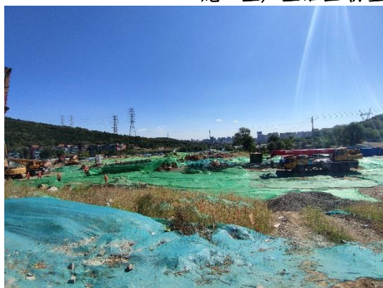
防尘网苫盖 洒水降尘 道路及管线工程区 (2022年9月)
