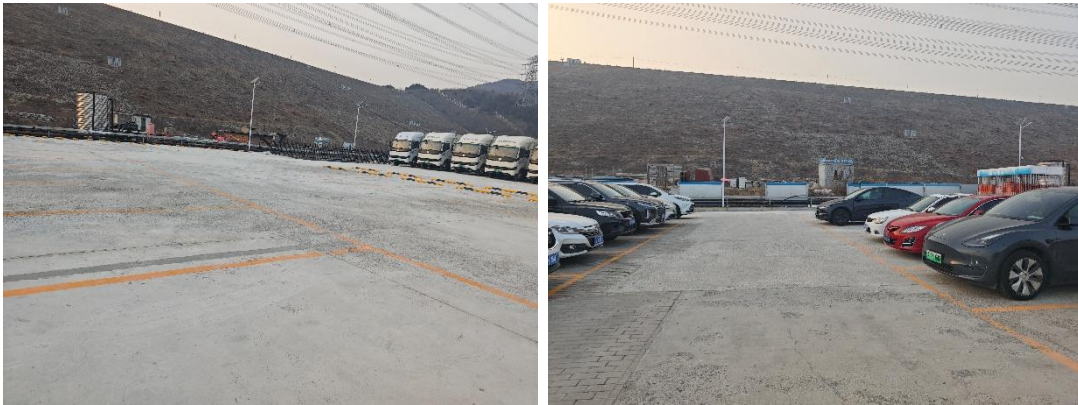
施工生产生活区现场照片
