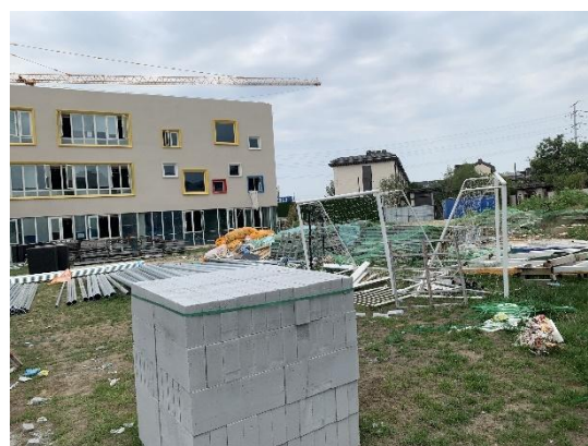
透水砖铺装（002 地块，2022 年 6 月）
