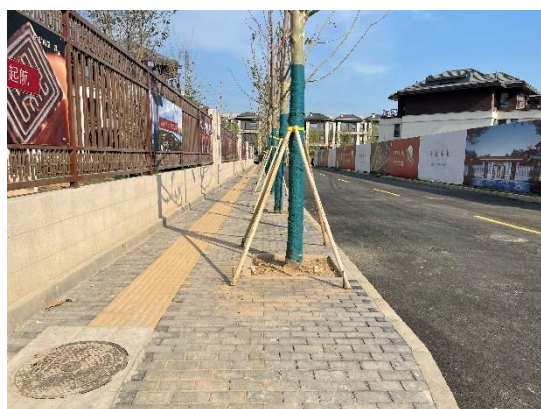
透水砖铺装（2021 年 4 月）
