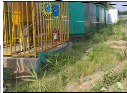
临时占地撒播草籽
