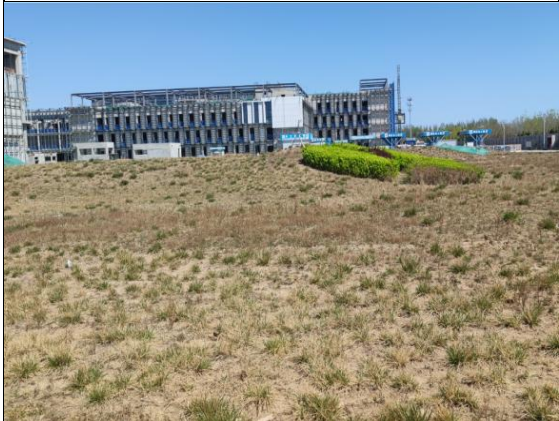
绿化工程区施工期临时绿化（2020 年）
