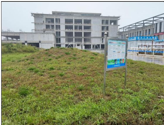
绿化工程区施工期临时绿化（2021 年）
