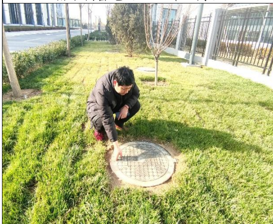
雨水调蓄池 (2023 年 12 月)
