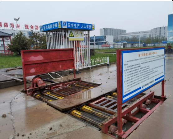
洗车沉淀池（2019 年）
